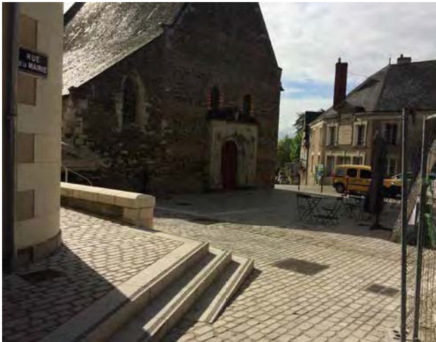
La mise en accessibilité de la mairie : emmarchement et rampe suivant la pente du terrain(Savennières, 49)
